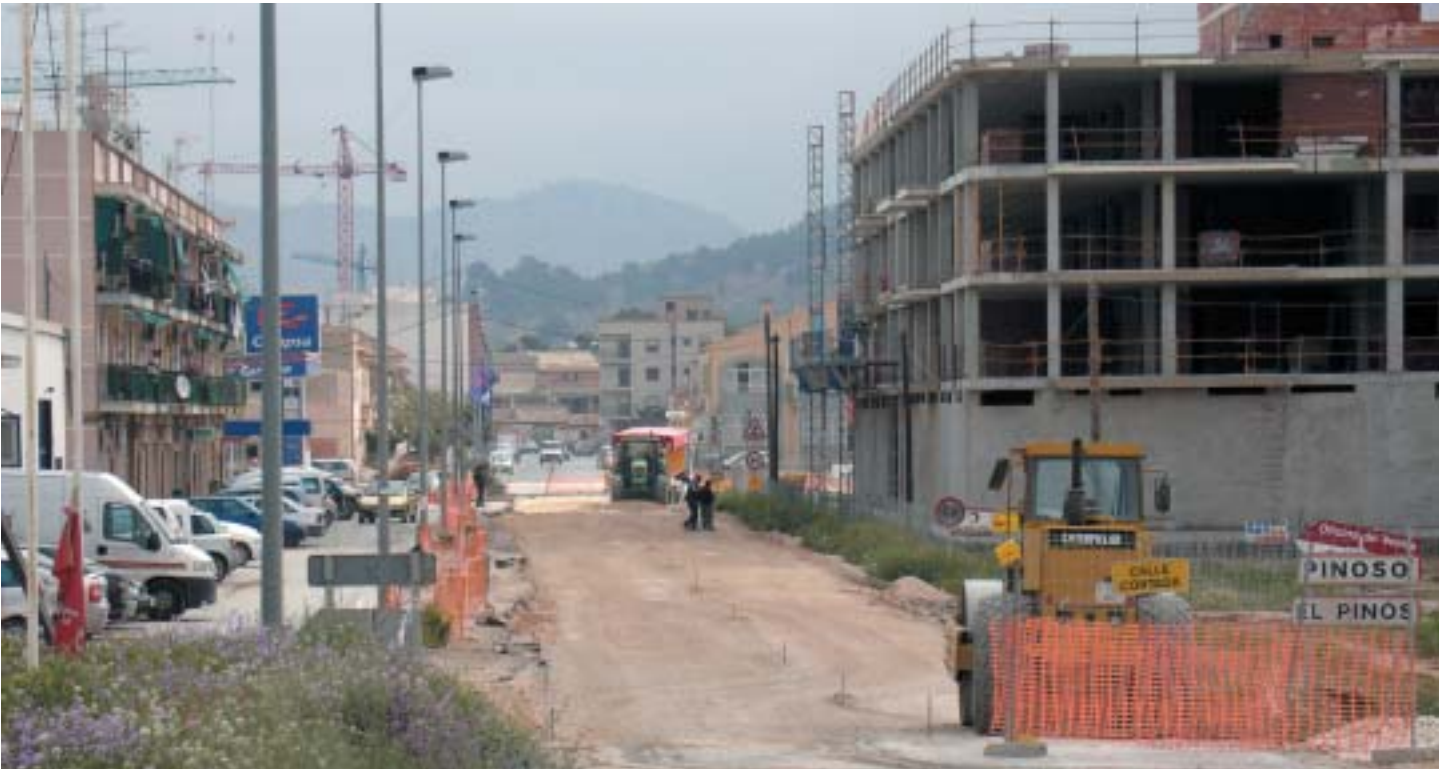
TRABAJOS DE ACONDICIONAMIENTO Y ARREGLO DE LA ENTRADA A PINOSO POR LA CARRETERA DE JUMILLA
