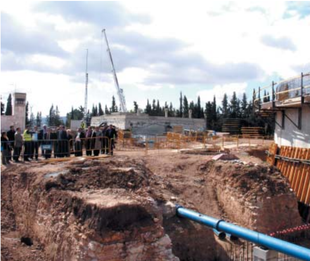
LA COMITIVA VISITÓ LAS OBRAS DEL NUEVO DEPÓSITO DE AGUA QUE SE CONSTRUYE EN PAREDÓN
