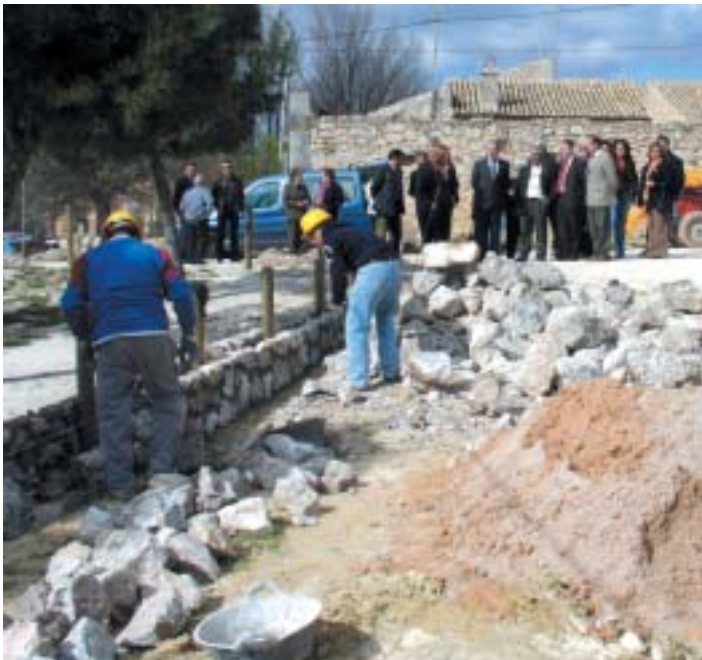
VISITANDO LAS OBRAS DE ADECENTAMIENTO DE LAS ERAS DE CULEBRÓN
